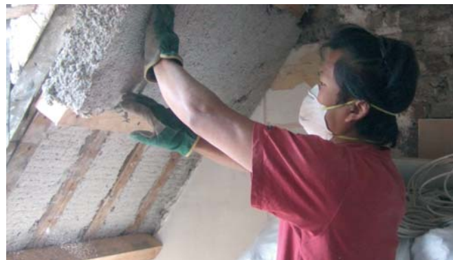
Pose de panneaux de cellulose pour l'isolation d'une maison.
